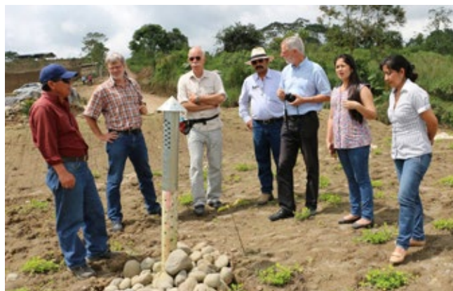
Aterro em San Miguel de los Bancos © Municipio San Miguel de los Bancos
