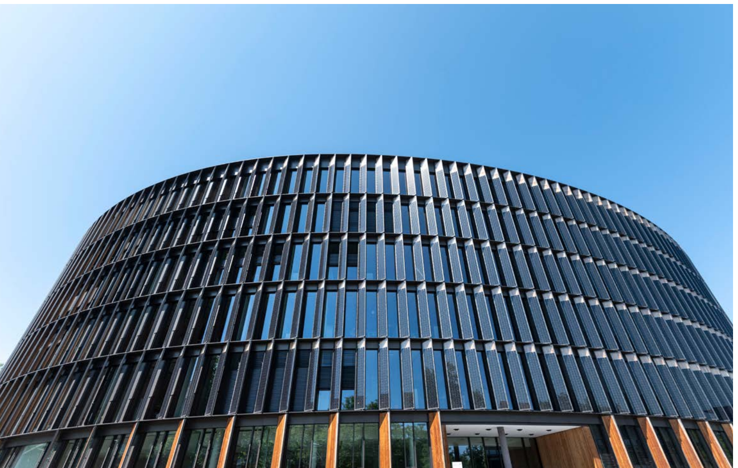
Abb. 16: Die mit Photovoltaik belegte Fassade des Rathaus im Stühlinger.
