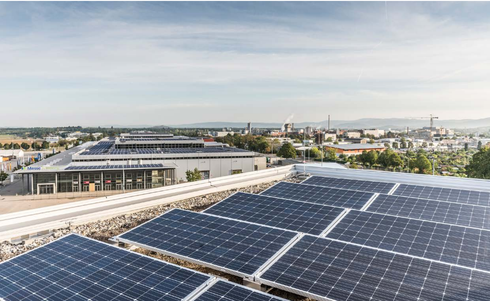
Abb. 17: Das mit Photovoltaik belegte Dach des Messegebäudes und Blick über das Gewerbegebiet Nord.
