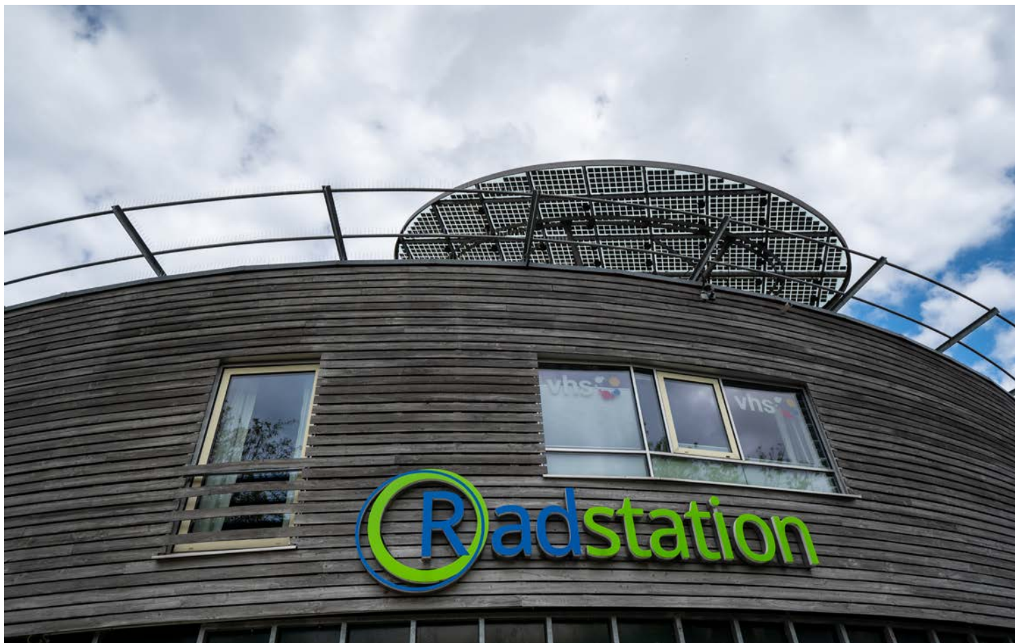
Abb. 20: Die Radstation am Freiburger Hauptbahnhof
