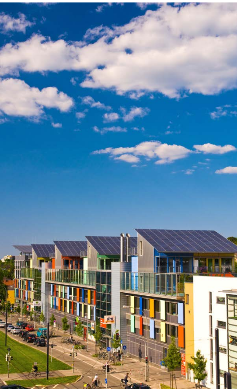
Abb. 14: Das sogenannte Sonnenschiff im Stadtteil Vauban, Teil der Solarsiedlung und klimapositives Gebäude.
