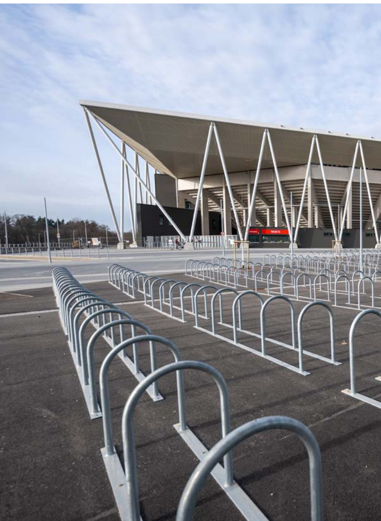
Abb. 18: Das neu errichtete Fußballstadion des Bundesligisten Sportclub Freiburg.
