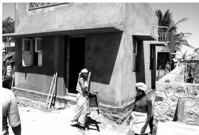
Fast fertig - das neue Haus für die indische Fischerfamilie ist bald bezugsfertig
