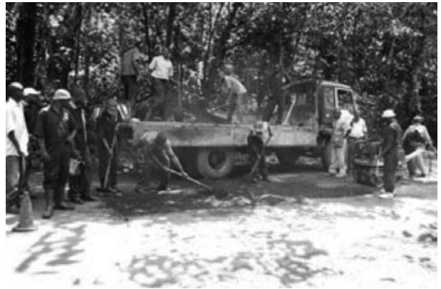
Ergebnis eines Bürgerhaushaltes: Straßenreparatur in Mbeya, Tansania.
