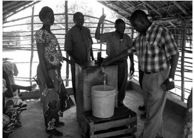
Abbildung 26: Trinkwasserversorgungssystem im Moshi Distrikt; Foto: Stadt Kiel
