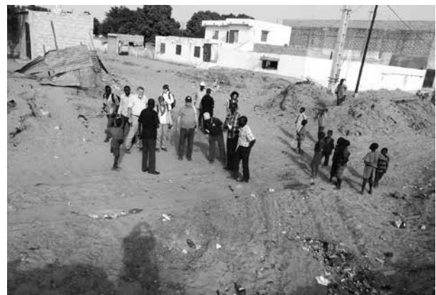
Abbildung 37: Schäden durch Überschwemmung in Thiès (Foto: Stadt Solingen)
