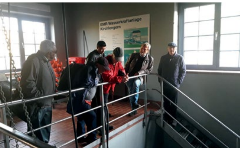
Besichtigung der Gasturbine © Kreis Herford
