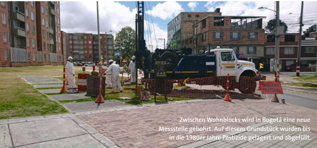
Zwischen Wohnblocks wird in Bogotá eine neue Messstelle gebohrt. Auf diesem Grundstück wurden bis in die 1980er Jahre Pestizide gelagert und abgefüllt.
