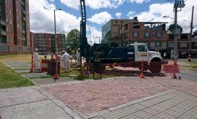
Das Projektteam aus Stuttgart und Bogotá führt Probebohrungen durch. Bevor in der kolumbianischen Hauptstadt neue Gebäude errichtet werden können, muss das entsprechende Gelände auf Kontaminationen durch frühere Nutzungen untersucht werden. © Hermann J. Kirchholtes
