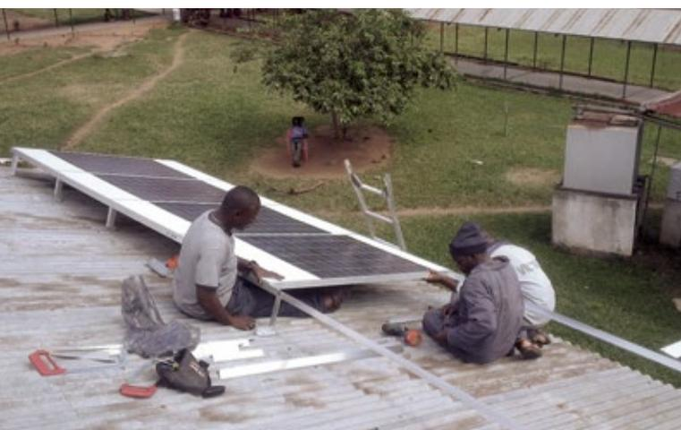
Mitarbeiter der Firma Ensol Ltd. montieren 2014 ein neues Solarstromsystem auf dem Dach des Kreiskrankenhauses Mkomaindo Hospital in Tansania. Die Partner aus dem Enzkreis und Masasi-Distrikt machten dies im Rahmen eines Nakopa-Projekts möglich. Seither ist die Energiegewinnung klimafreundlicher und die Stromversorgung stabiler.
